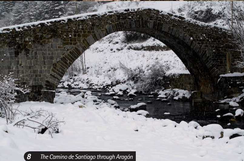
▲ Bridge, Canfranc Pueblo
